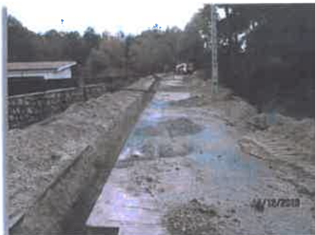
FOTO 5 - FRENTE DE TRABALHOS DE MOUÇOS DA EMPREITADA "SAR CIDADE - MOUÇOS - LIGAÇÃO À ALTA NA EN 15 - EXECUÇÃO DA REDE DE DRENAGEM DE ESGOTOS DA ALDEIA DE SANGUINHEDO"
