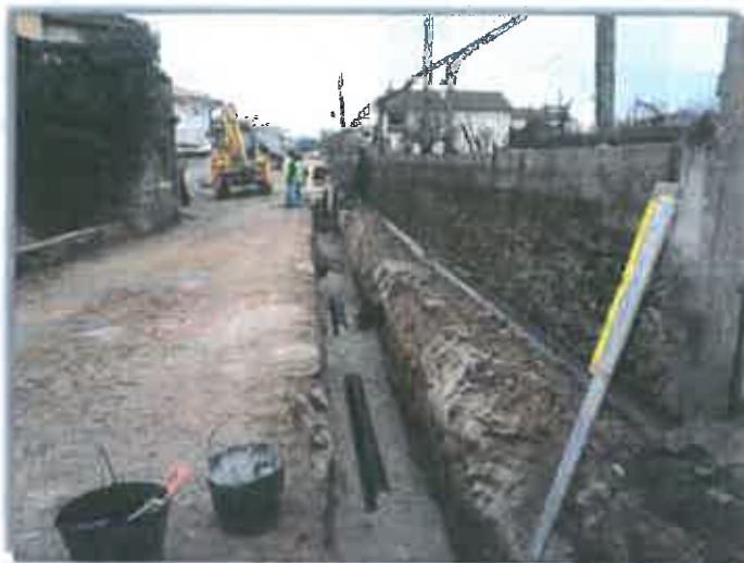
FOTO 6 - - FRENTE DE TRABALHOS DE - FRENTE DE TRABALHOS DE VALE DE NOGUEIRAS DA EMPREITADA "SAR CIDADE - AMPLIAÇÃO DA REDE DA CIDADE - REDE DE DRENAGEM DE ESGOTOS E REMODELAÇÃO DA REDE DE ABASTECIMENTO DE ÁGUA DE CARVALS, VALE DE NOGUEIRAS E ASSENTO E REDE DE DRENAGEM DE ESGOTOS DAS ALDEIAS DE NOGUEIRA, TANHA E ALFOLÕES DA FREGUESIA DE NOGUEIRA E DE VILARIMHO DE TANHA DA FREGUESIA DE ARAÇAS
