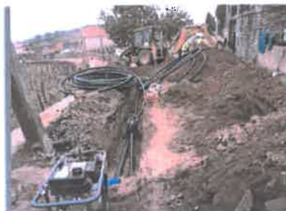
FOTO 4 - FRENTE DE TRABALHOS DE NOGUEIRA DA EMPREITADA PSAR CIDADE - AMPLIAÇÃO DA REDE DA CIDADE - REDE DE DRENAGEM DE ESGOTOS E REMODELAÇÃO DA REDE DE ABASTECIMENTO DE ÁGUA DE CARVAS, VALE DE NOGUEIRAS E ASSENTO E REDE DE DRENAGEM DE ESGOTOS DAS ALDEIAS DE NOGUEIRA, TANHA E ALFOLÕES DA FREGUESIA DE NOGUEIRA E DE VILARINHO DE TANHA DA FREGUESIA DE AÇAÇ
