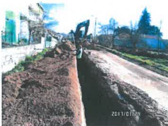
FOTO 1 - FRENTE DE TRABALHO DE SANGUINHEDO DA EMPREITADA "SAR CIDADE - MOUÇOS - LIGAÇÃO À ALTA NA EN 15 - EXECUÇÃO DA REDE DE DRENAGEM DE ESGOTOS DA ALDEIA DE SANGUINHEDO"
