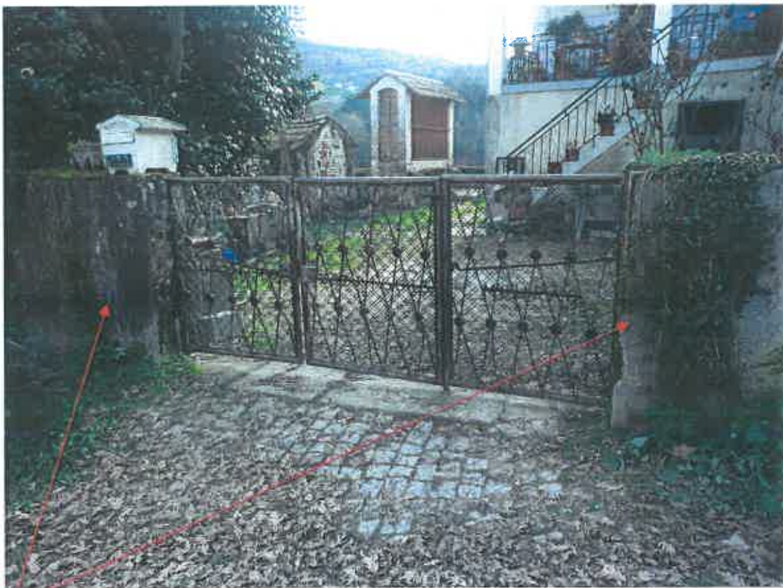
Dois Pilares e portão – antes da retirada do portão
