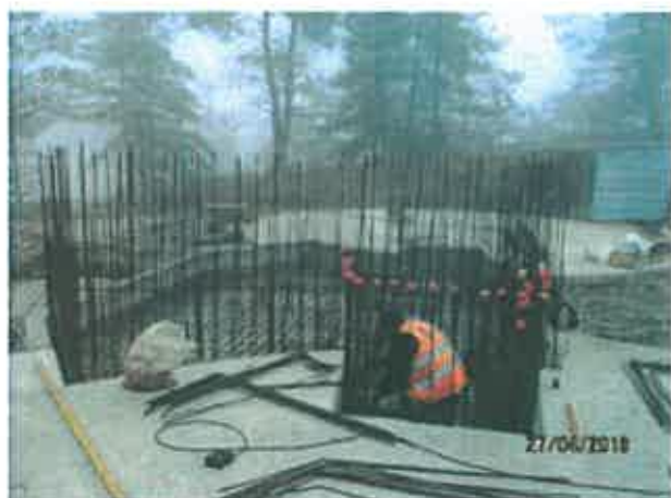
Foto 2 - Início dos trabalhos no Reservatório de Mascoselo
