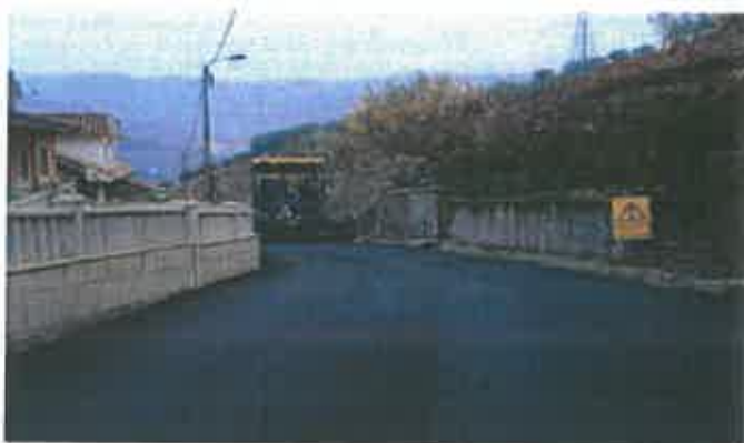
FOTO 1 - PAVIMENTAÇÃO EM TANHA
