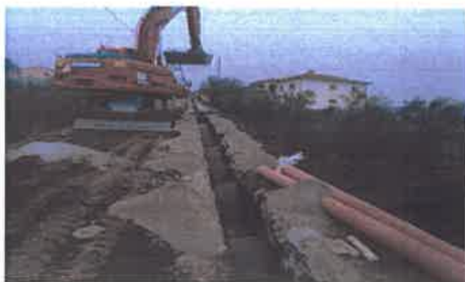
FOTO 8 - INSTALAÇÃO DE COLETORES EM BUJÕES
