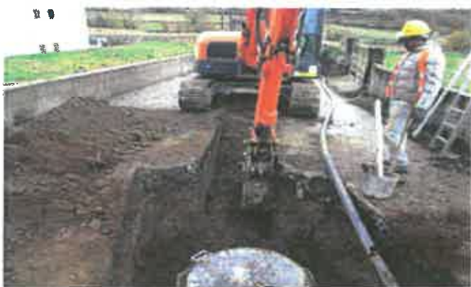
FOTO 7 - ABERTURA DE VALA EM VILA COVA
