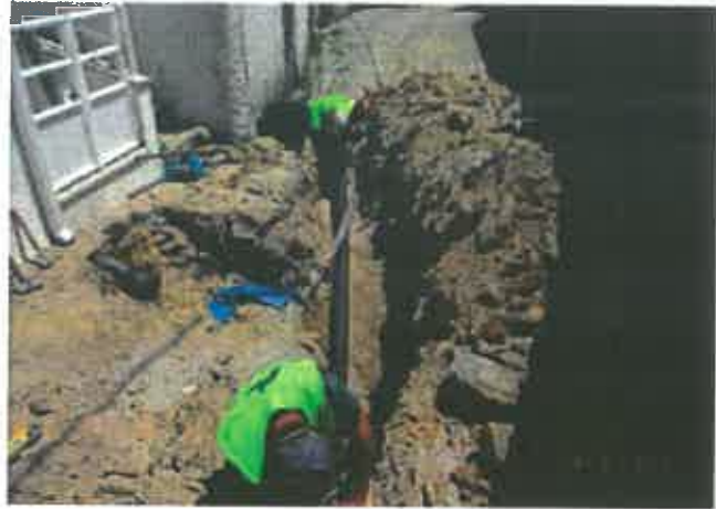
FOTO 4 - EXECUÇÃO DE RAMAL DOMICILIÁRIO EM ARRABÃES
