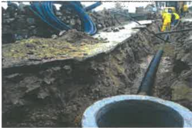
FOTO 6 - APLICAÇÃO DE TUBAGEM EM JORJAIS, MOUÇOS
