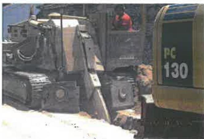
FOTO 3 - ABERTURA DE VALA EM SANGUINHEDO COM RECURSO A VALADORA
