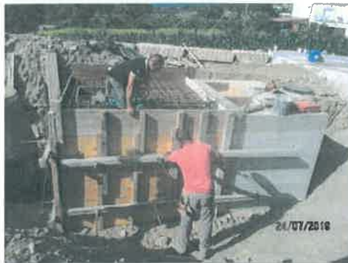
FOTO 5 - CONSTRUÇÃO DE ELEVATÓRIA EM VILA COVA
