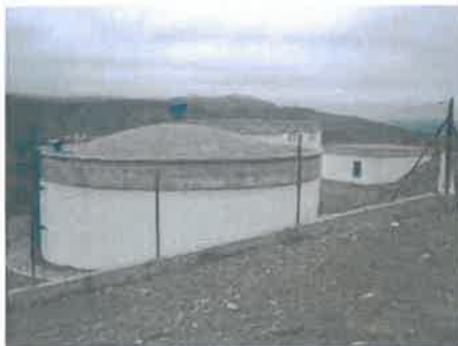
Foto 3 - RESERVATÓRIO DE VIARIZ DA POÇA
