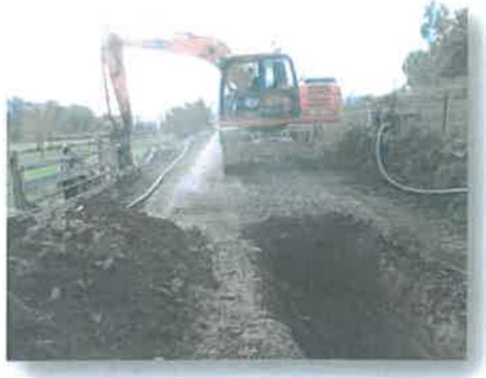
FOTO 4 - INSTALAÇÃO DE REDE DE ABASTECIMENTO
