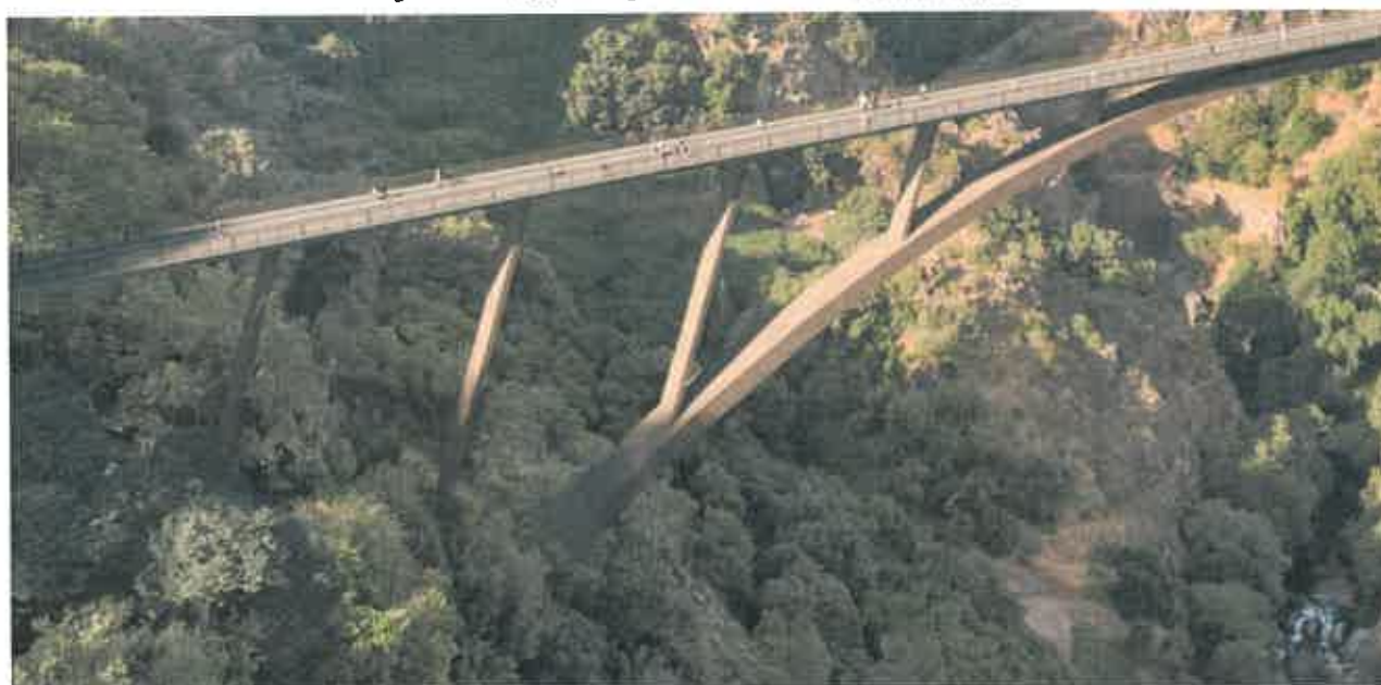
Figura 16 – Fotomontagem de vista parcial da ponte em betão armado
