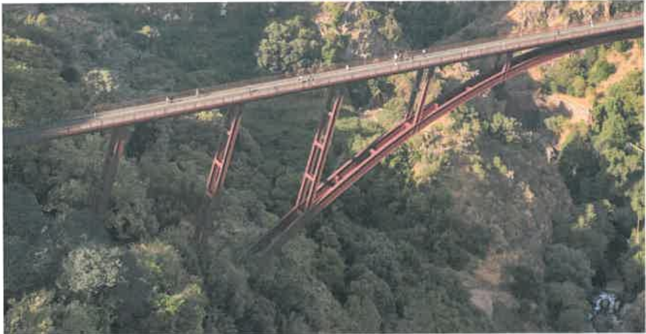
Figura 14 – Fotomontagem de vista parcial da ponte em aço
