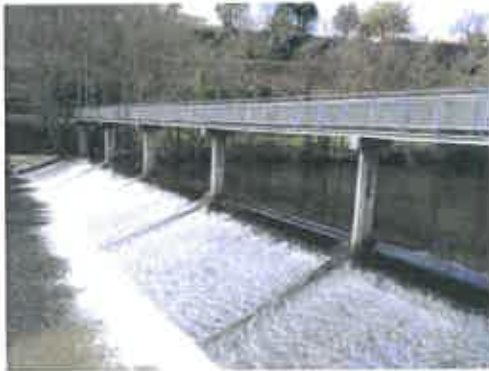
vista geral da ponte pedonal existente a reabilitar
