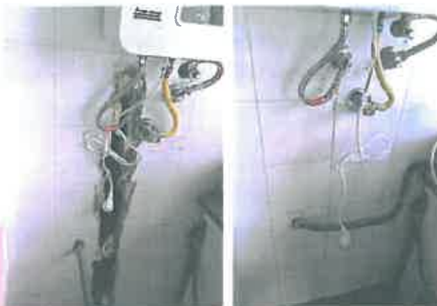
Figura 18 - Exemplo de intervenção de reparação
