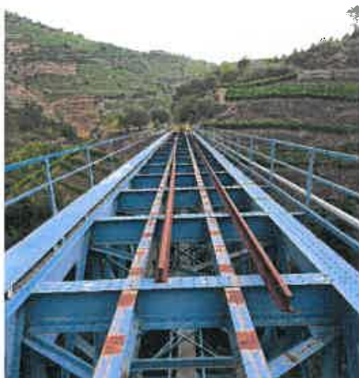
Imagem 9 - Ponte sobre o rio Tanha - Situação atual
