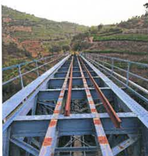
Imagem 9 - Ponte sobre o rio Tanha - Situação atual
