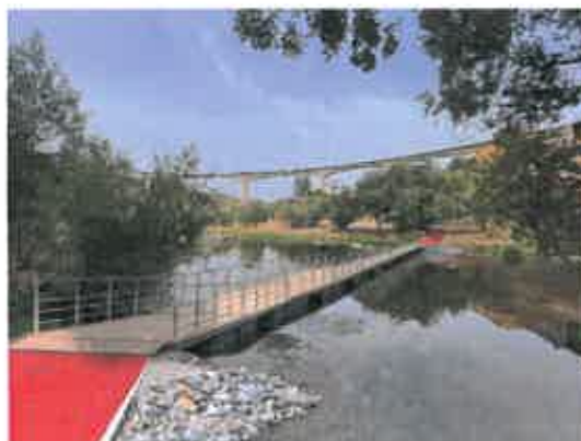
Imagem 6 - Travessia do Corgo – Ponte flutuante
