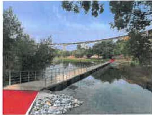
Imagem 6 - Travessia do Corgo – Ponte flutuante
