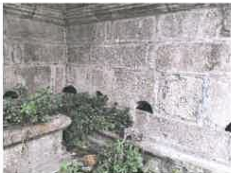
Fot. 3 Pormenor das aberturas que dão acesso ao canal interior
