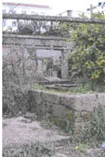
Fot. 11 Poço no patamar lateral
