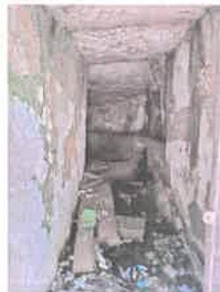
Fot. 10 Acesso à mina no tardoz da fonte
