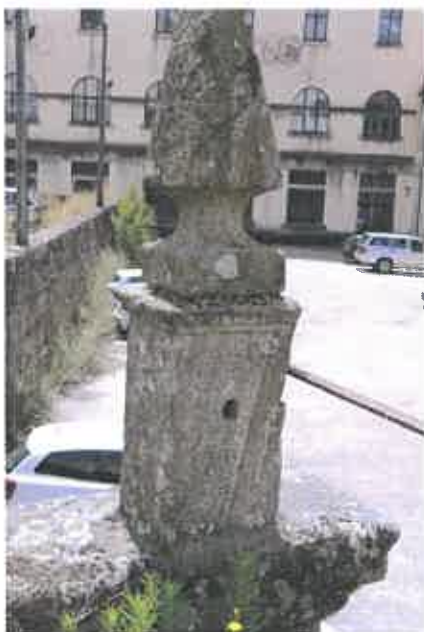
Fot. 27 Desalinhamento dos elementos decorativos face à sua base
