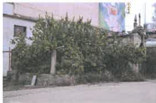
Fot. 12 Patamar lateral com 4 colunas, antes do corte de vegetação
