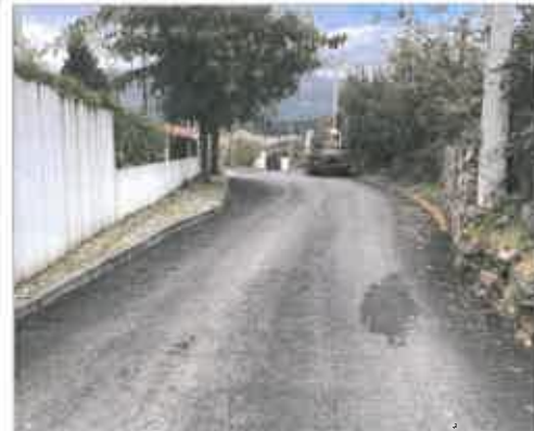
Fig. 6 - Troço da Rua António José dos Santos, junto à Urbanização Vila Sol.
