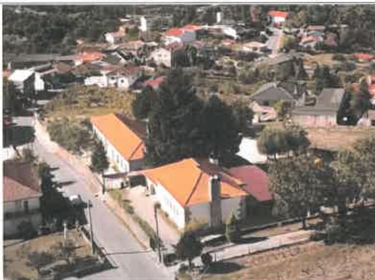
Figura 1 – Vista área da Escola EB1 e JI de Vila Seca
