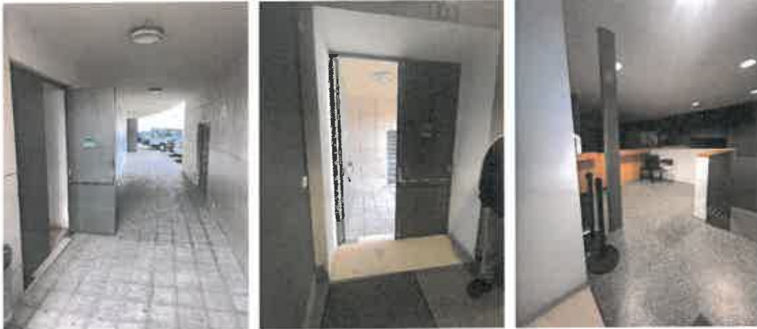
Fig 1, 2 e 3 | Acesso, desde o exterior, ao palco do grande auditório
