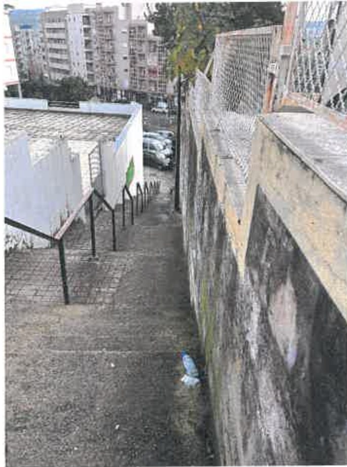
Figura 4 – Situação existente – Acesso vertical entre a Praceta das Hortas e a Rua Cidade de Espinho
