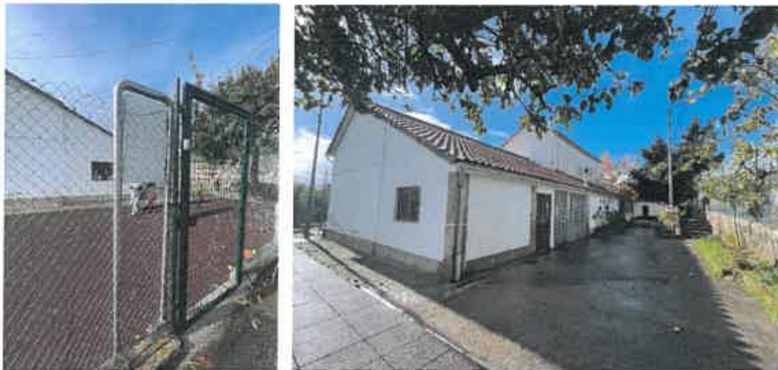
Fig 2 e 3 | Acessos desde via pública e entrada de nível - a necessitar de intervenção para melhoria das acessibilidades
