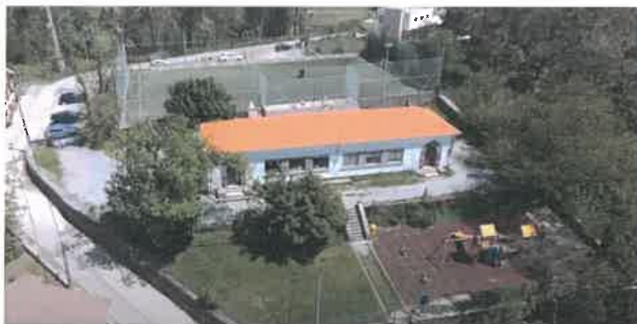
Figura 1 – Vista área da Escola EB1 de Vendas de Cima
