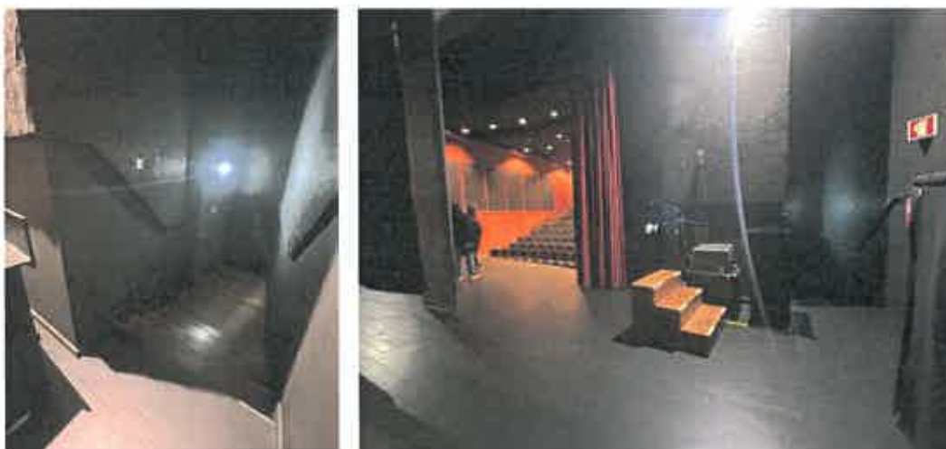
Fig 7 e 8 | Acesso ao palco do pequeno auditório - a necessitar de intervenção para melhoria das acessibilidades
