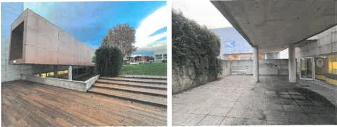
Fig 3 e 4 | Acesso proposto ao Grémio Literário – a necessitar de intervenção para melhoria da acessibilidade
