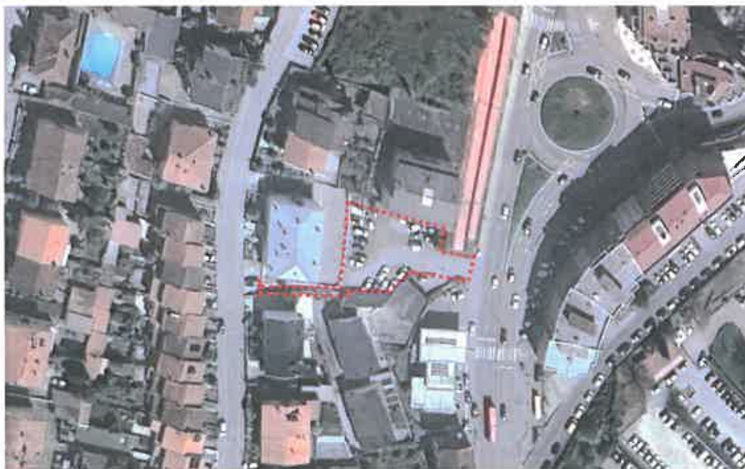
Figura 2 – Área de intervenção com vista aproximada (Nota: Imagem com direção para norte)
