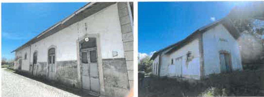
05 Edifício da antiga estação de Abambres Gare – vista nordeste 06 Edifício da antiga estação de Abambres Gare – hangar - vista oeste
