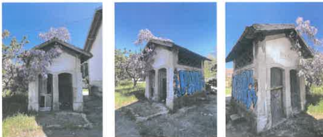
07, 08 e 09 Edifício wc exterior
