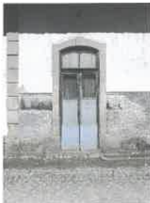
10 Portas acesso estação (em madeira, a recuperar)
