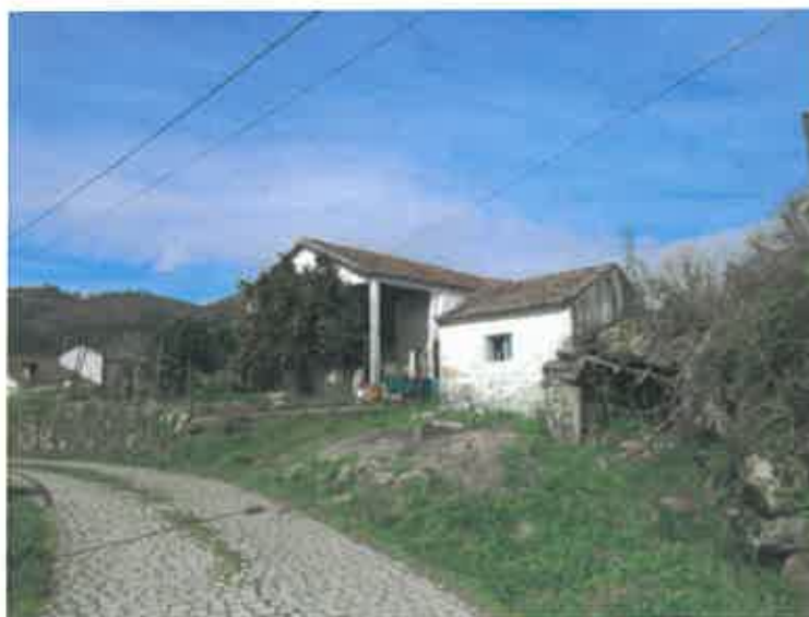
Figura 1 – Zona de chegada
