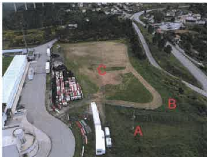
Fotografia 3 - A - PT aéreo a alterar. B - Novo PT cabine. C - Novo campo relva sintética.
