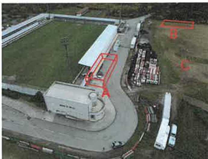
Fotografia 2 - A - Edifício novo balneário. B - Edifício Sede AFVR. C - Novo campo relva sintética.
