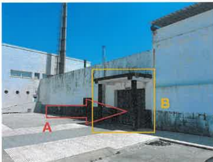
Fotografia 1 - A - Acesso de atletas ao campo principal, a partir dos novos balneários. B - Pilares e laje a demolir
