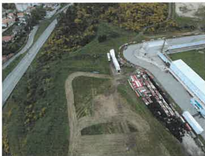
Fotografia 5 - Vista geral da área de intervenção.
