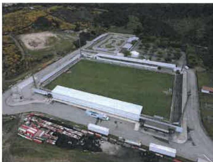
Fotografia 4 - Vista geral da área de intervenção.
