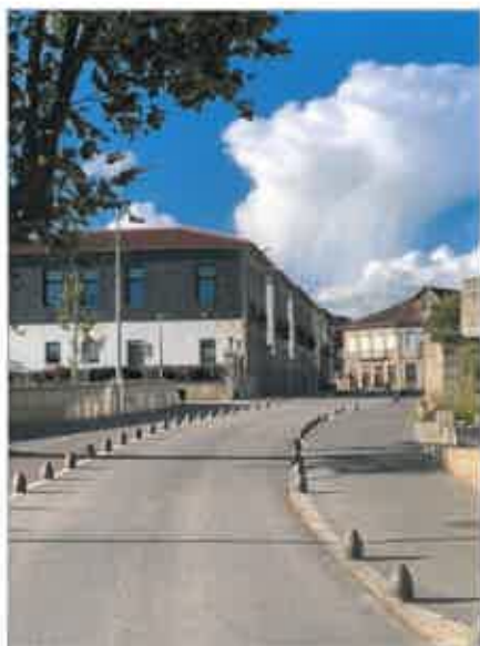
Fig. 1 – Dissuasores existentes na Rua Madame Brouilhard.
