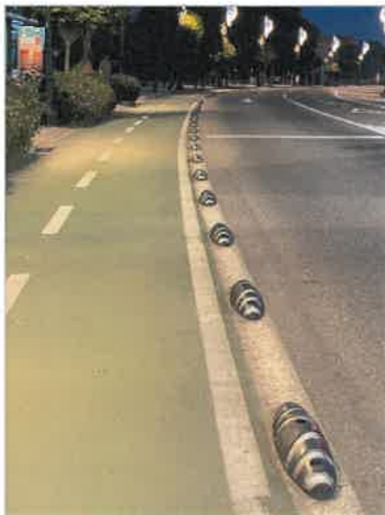
Fig. 10 – Módulos da marca Zicla a separar a faixa de rodagem da ciclovia na cidade de Vigo.
