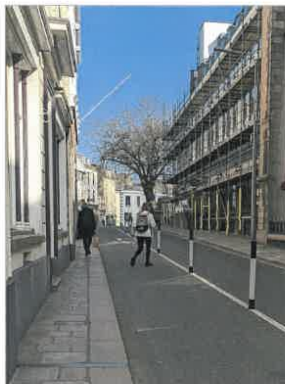
Fig. 11 – Pilaretes flexíveis (80/90cm) a separar a faixa de rodagem da ciclovia. Imagem Google Maps.
