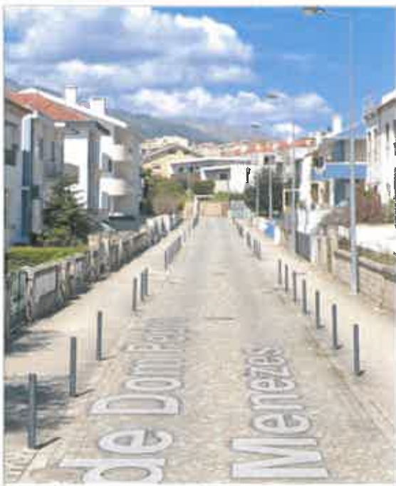
Fig. 5 – Pilaretes colocados na Rua Dom António de Azevedo. Imagem Google Maps.
