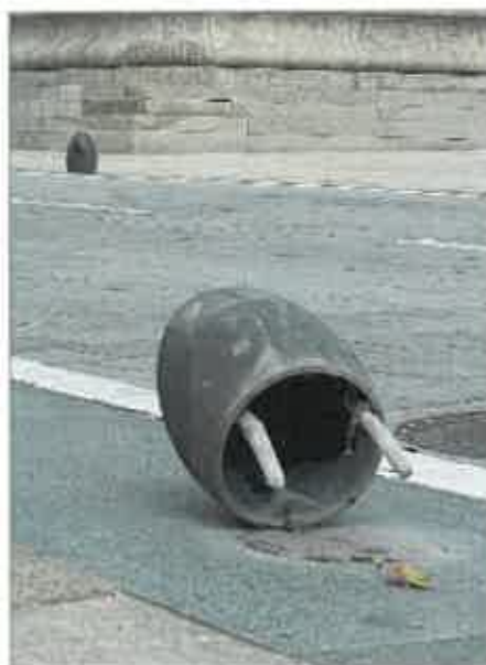
Fig. 4 – Dissuasor (fixado com parafusos) danificado após embate de veículo.
